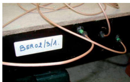
Afb. 6 Hygrothermische sonde die horizontaal in de dekvloer geplaatst werd.
