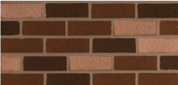
Afb. 22 en 23 Traditioneel metselwerk. Betonmetselstenen (geval 1).
