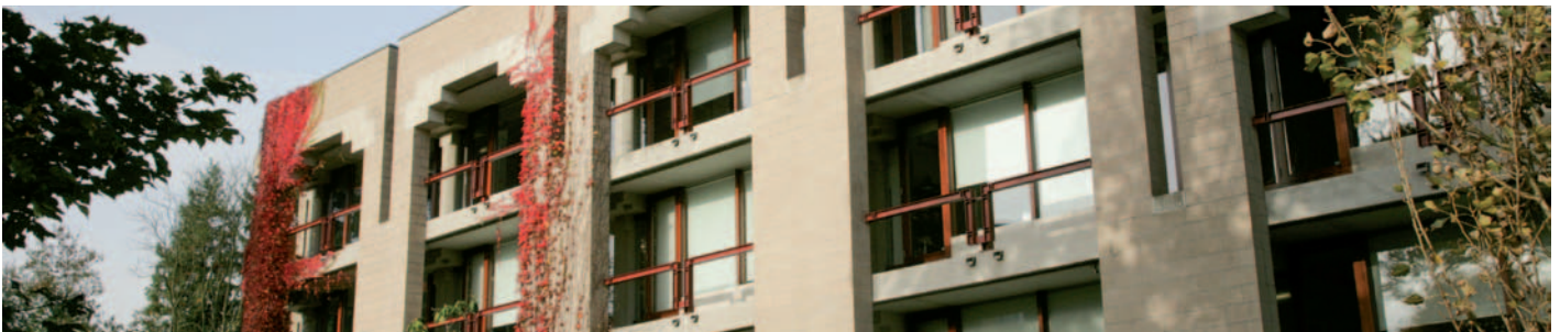
Afb. 16 Voorbeeld van metselwerk uit betonmetselsteen.
