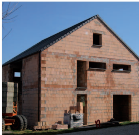
Afb. 9 Metselwerk uit bakstenen met dunne voegen (voegen : 0,5-3 mm).
