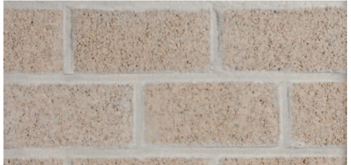
Afb. 21 Traditioneel metselwerk met gepigmenteerde mortel voor de voegen. Bakstenen (geval 1).
