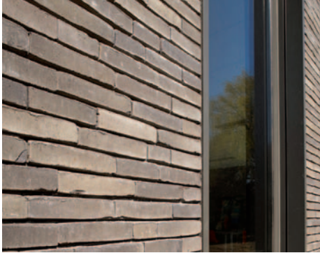
Afb. 28, 29 en 30 Gelijmd metselwerk met dunne voegen. Bakstenen (geval 4).
