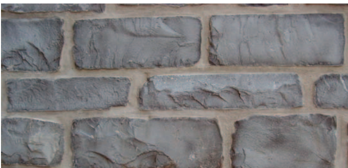
Afb. 24 Traditioneel metselwerk. Natuursteen (geval 1).
