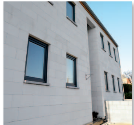
Afb. 10 Metselwerk uit cellenbeton met dunne voegen (voegen : 0,5-3 mm).
