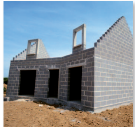
Afb. 8 Traditioneel metselwerk uit betonmetselstenen (voegen : 10-12 mm).
