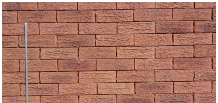
Afb. 25 Gelijmd metselwerk met dunne voegen. Regelmatige bakstenen (geval 1).
