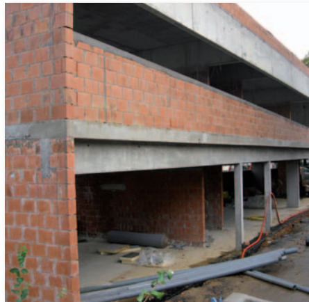
Afb. 7 Traditioneel metselwerk uit bakstenen (voegen : 10-12 mm).
