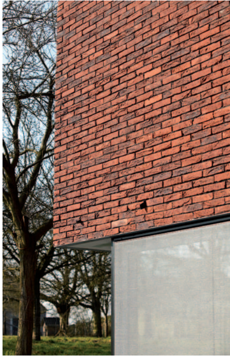
Afb. 28, 29 en 30 Gelijmd metselwerk met dunne voegen. Bakstenen (geval 4).
