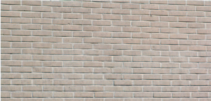
Afb. 20 Traditioneel metselwerk. Bakstenen (geval 1).
