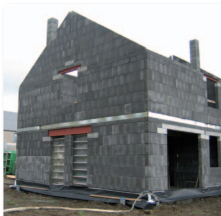
Afb. 11 Metselwerk uit lichte betonmetselstenen met dunne voegen (voegen : 0,5-3 mm).
