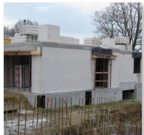
Afb. 12 Metselwerk uit metselstenen van kalkzandsteen met dunne voegen (voegen : 0,5-3 mm).
