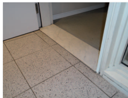
Afb. 2 Plaatsing van een stenen deurderpel
