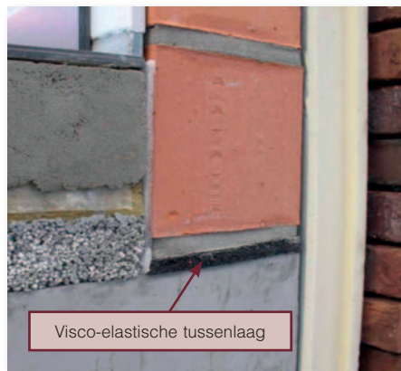
Visco-elastische tussenlaag die de flankerende geluidstransmissie beperkt ter hoogte van de muurvloerverbindingen
