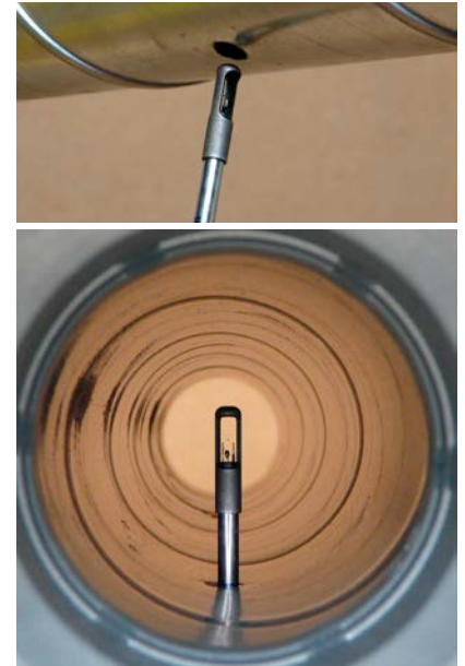
11 | Gebruik van een kleine sonde in een cirkelvormig kanaal.
