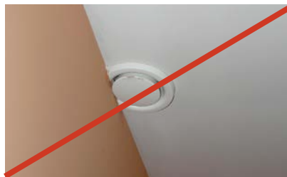
4 | Slecht geplaatste ventielen (links en midden) en een voorbeeld van een correcte positionering die een meting mogelijk maakt (rechts).
