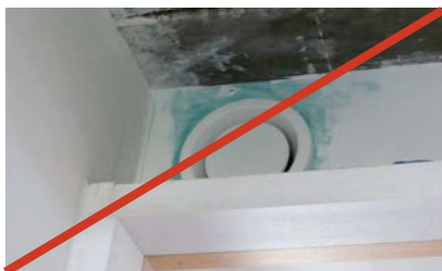
4 | Slecht geplaatste ventielen (links en midden) en een voorbeeld van een correcte positionering die een meting mogelijk maakt (rechts).
