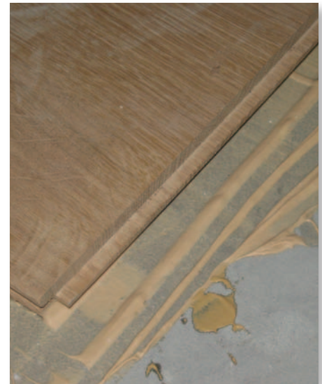
Afb. 1 De aard van de lijm oefent een reële invloed uit op de contactgeluidsisolatie van de vloeren
