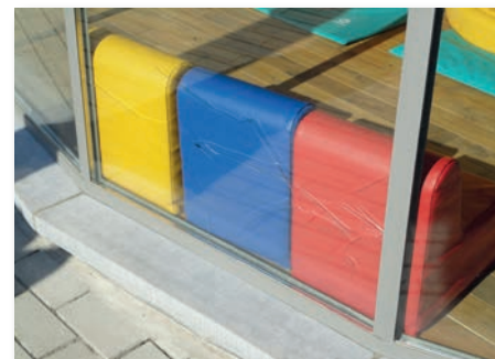
Afb. 2 Thermische breuk onder invloed van de binnenomgeving
