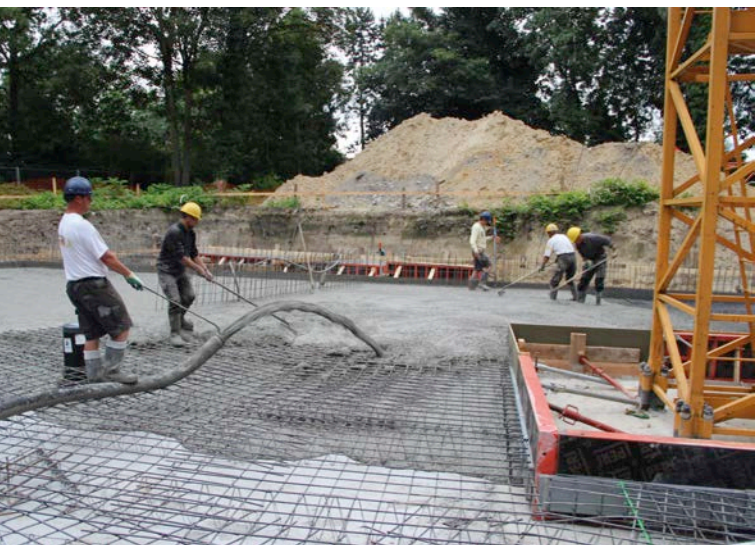
Uitvoering van de funderingsplaat met een combinatiewapening
