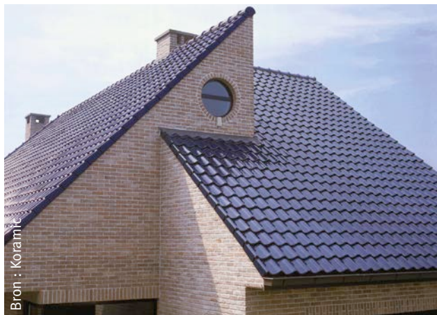
2 | Correct uitgevoerd pannendak.
