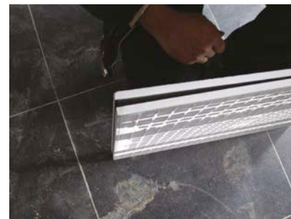
1 | Keramische tegel met een ontoelaatbare afwijking op de vlakheid
