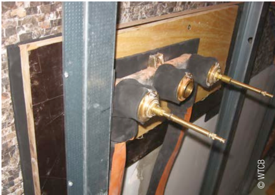
4 | Bevestiging van kranen en leidingen in de spouw van een voorzetwand
