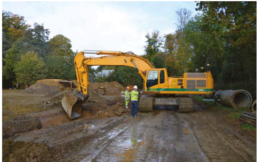
1 | 3D-sturing biedt tal van mogelijkheden voor de voorbereiding van rioleringswerken.
