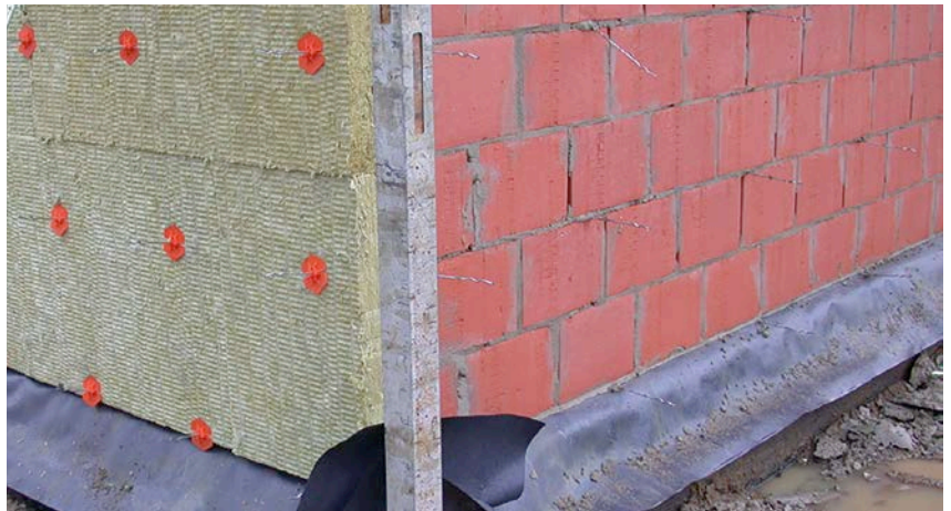
Spouwhaken die in de mortellaag van de dragende wand ingewerkt zijn
