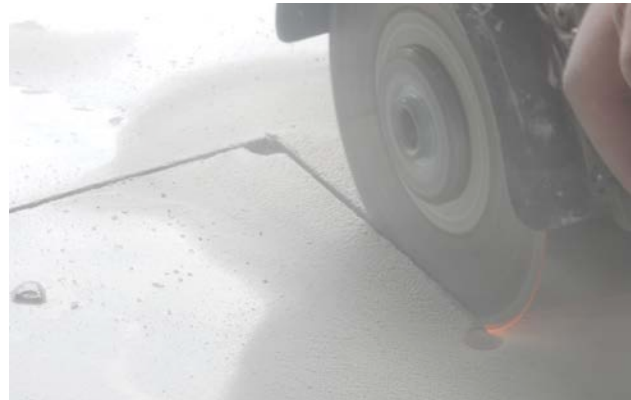
2 | Het maken van een rechthoekige uitsparing door gaten te boren in de hoekpunten en de zijden vervolgens uit te snijden met een haakse slijper
