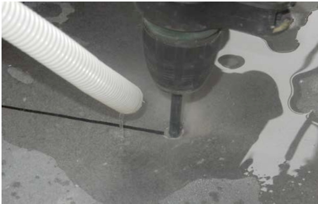
2 | Het maken van een rechthoekige uitsparing door gaten te boren in de hoekpunten en de zijden vervolgens uit te snijden met een haakse slijper
