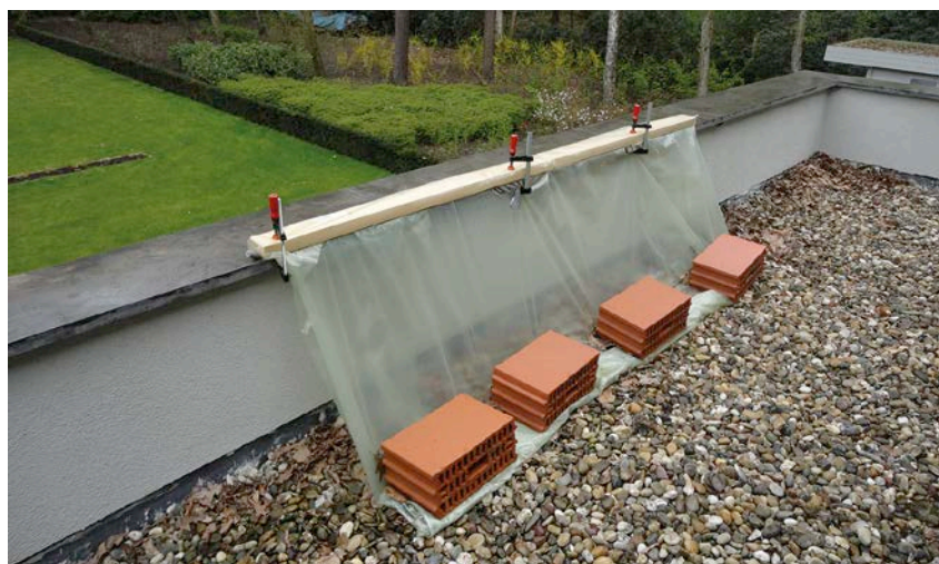
1 | Het tijdelijk van slagregen afschermen van een gedeelte van de dakopstand
