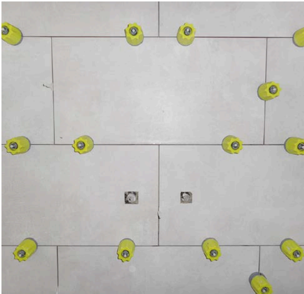
2 | Toepassing van een nivelleersysteem met draaistuk op een douche-wand.
