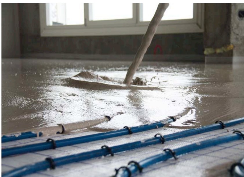
Uitvoering van een calciumsulfaatgebonden dekvloer.
