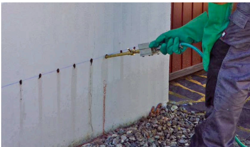
1 | Uitvoering van een injectiebehandeling tegen opstijgend grondvocht.
