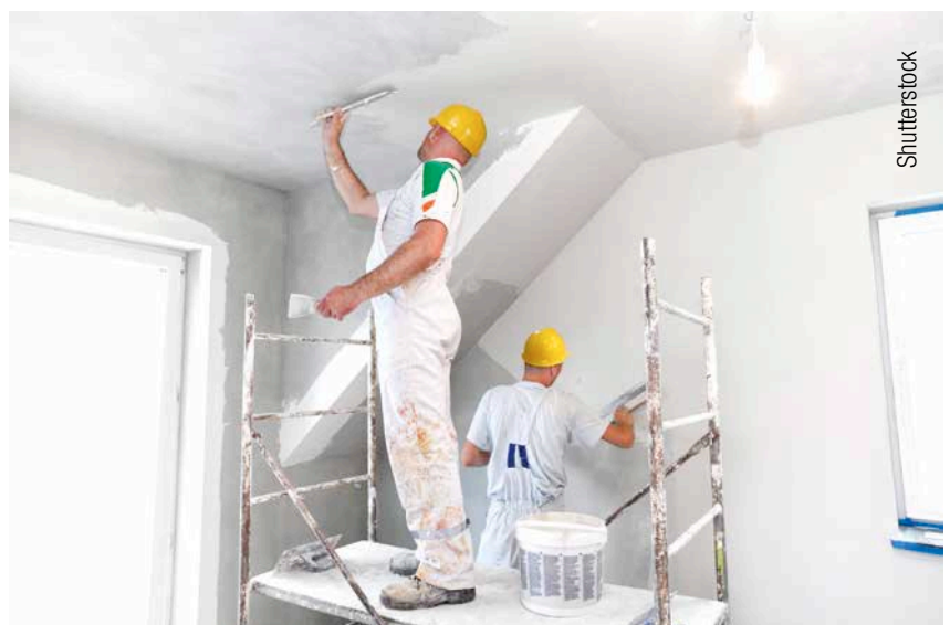
Aanbrengen van een voorbereidingsplamuur.
