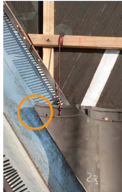
3 | De pannen moeten gezaagd worden, hun bovenhoek moet afgesneden worden en ze moeten op de bebording bevestigd worden.
