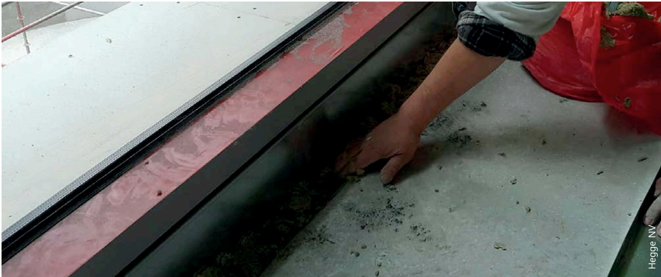
4 | Opvulling met rotswol van de ruimte tussen de vlamdichte plaat en de compartimentsvloer om te komen tot een brandwerende afdichting van de brandweerstandsklasse EI 60.
