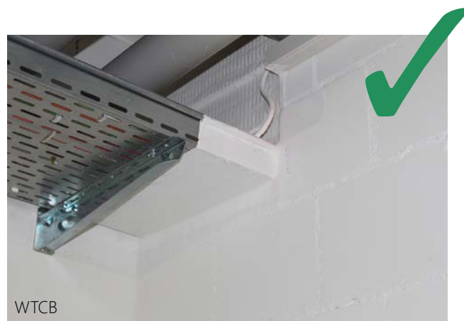
2 | Goede uitvoering van een brandwerende doorvoering van een kabelgoot.
