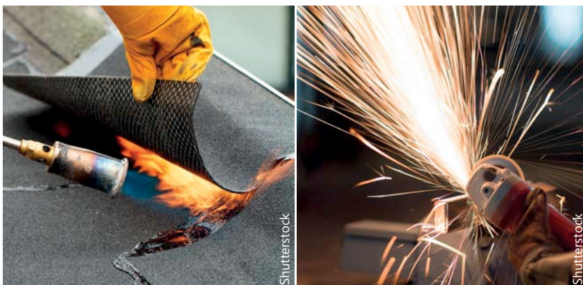
1 | Voorbeelden van op de bouwplaats uitgevoerde werkzaamheden met hittepunten.
