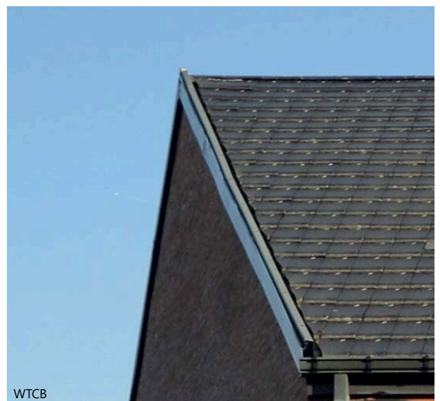
2 | Afwerking van de dakranden met een specifiek profiel.
