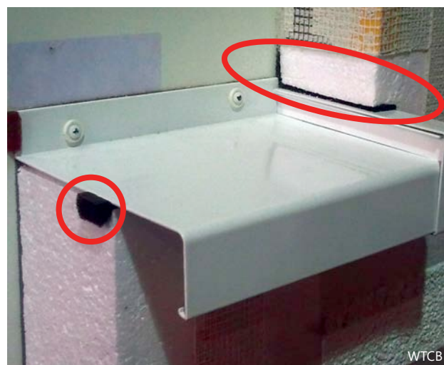
1 | Waterdicht maken van een vensterdorpel door middel van voorgecomprimeerde afdichtingsbanden.
