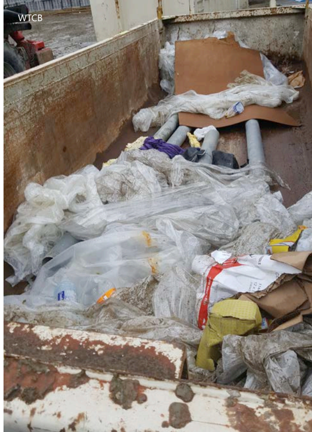
2 | Links: pilootwerf waarop het plastic verpakkingsafval apart ingezameld wordt Rechts: conventionele praktijk met een gemengde container waarin het plasticafval veel plaats inneemt.
