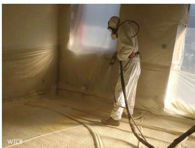
1 | Uitvoering van ter plaatse gespoten polyurethaanschuim.
