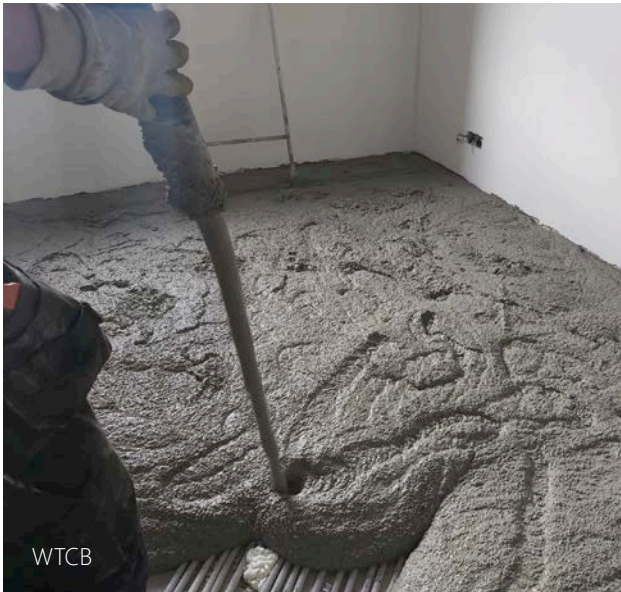
2 | Uitvoering van een uitvulling uit EPS-mortel.
