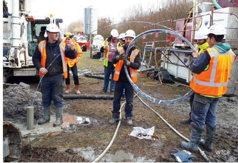
2 | Toepassing van optischevezelsensoren in een grondverdringende schroefpaal (links) en in een micropaal (rechts).
