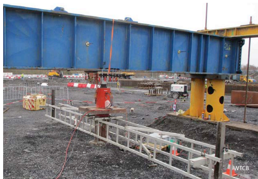
3 | Opzet van een paalbelastingsproef
