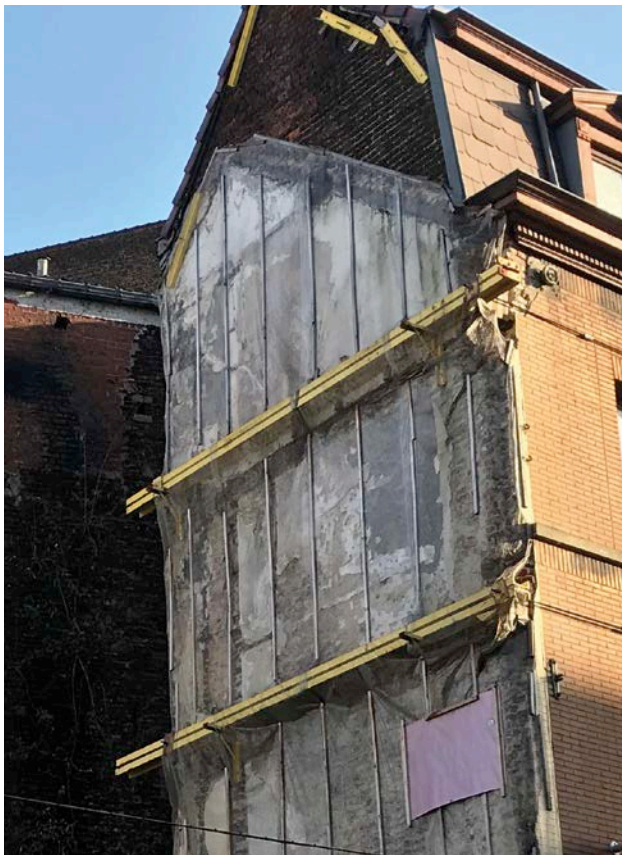
2 Stabilisatie van een gemene muur met metalen profielen die verankerd zijn in de aangrenzende gevels.
