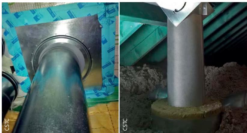
2 | Accessoires spécifiques permettant d'assurer la continuité de l'étanchéité à l'air et de l'isolation thermique.
