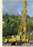
Antilles (colonnes ballastées)
