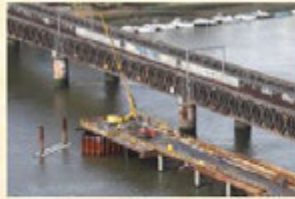
Pont sur l'Adour à Bayonne (jet grouting)
