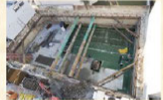
SCI Atland, Le Vésinet (paroi en Deep Soil Mixing)
