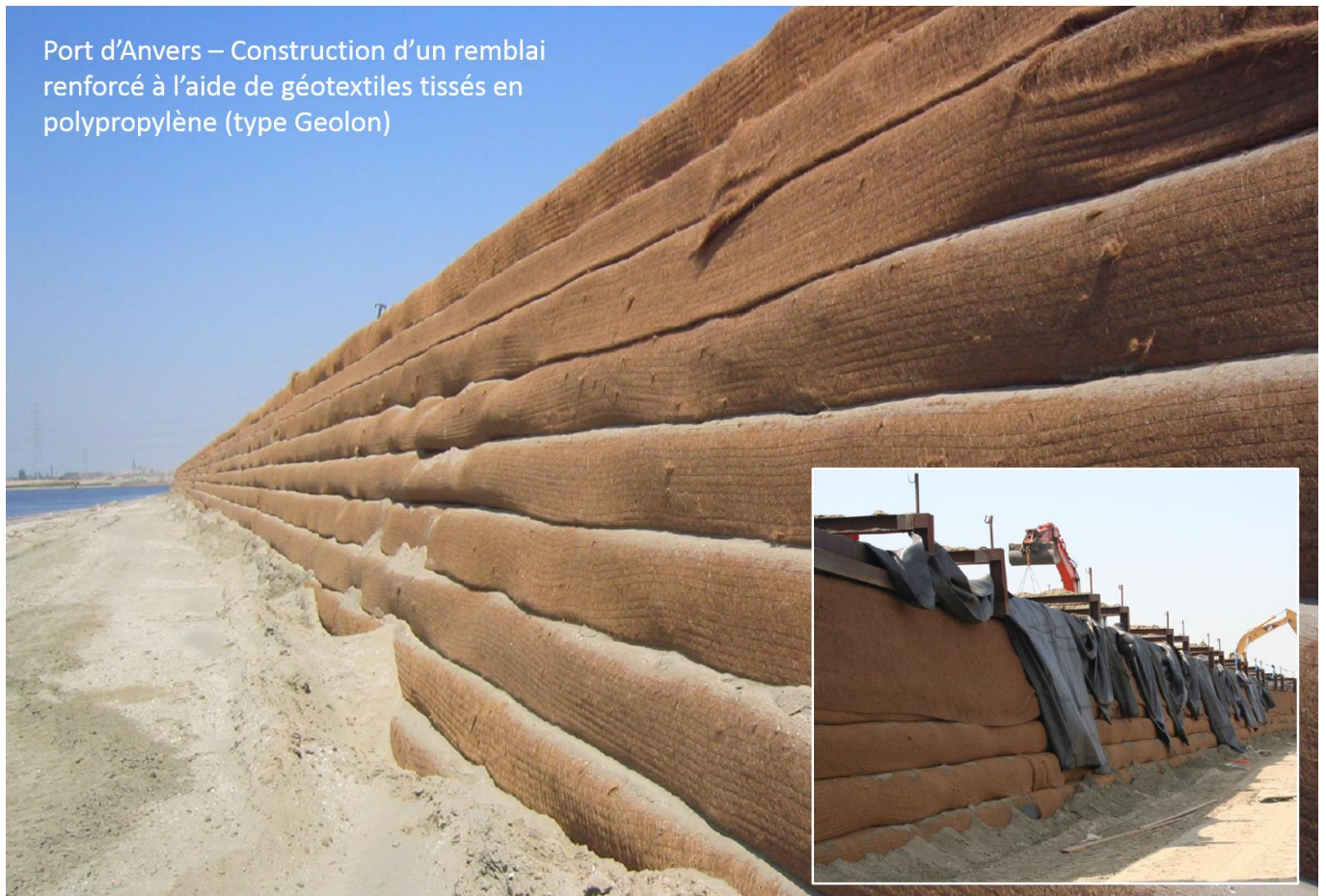
Figure 1. Exemple d'application en Belgique (1) : Remblais renforcés au moyen de géotextiles tissés. Source : Texion et TenCate.
