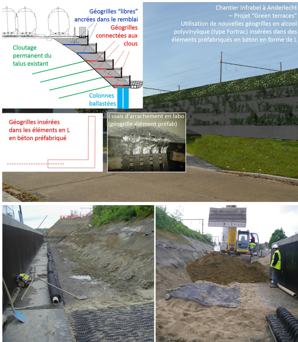
Figure 4. Exemple d'application en Belgique (4) : Remblai renforcé au moyen de géogrilles insérées dans des éléments préfabriqués en béton en forme de L. Source : Emergo, Huesker et TUC RAIL (Verstraelen et al., 2012 et 2013).
