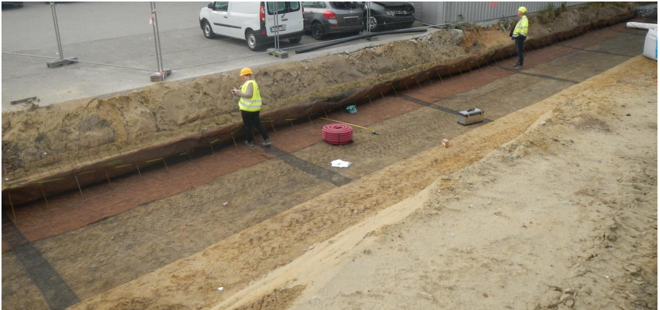
Figure 15. Première géogridde à instrumenter (NIVEAU 1 – remblai renforcé incliné). Source : CSTC.
