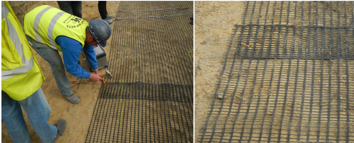
Figure 20. Ancrage de la géogridde à instrumenter dans le massif du remblai. Source : CSTC.
