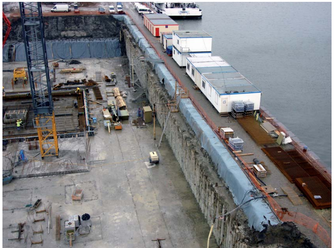
Figuur 2 Foto van een soilmix wand met een grond- en waterkerende functie (CVR).
