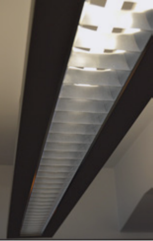
▲ Metalen lamellen in een armatuur vermijden rechtstreeks zicht in de lichtbron
