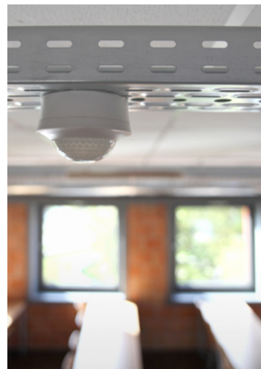
▲ Toepassing van een afwezigheidsdetector in een klaslokaal
